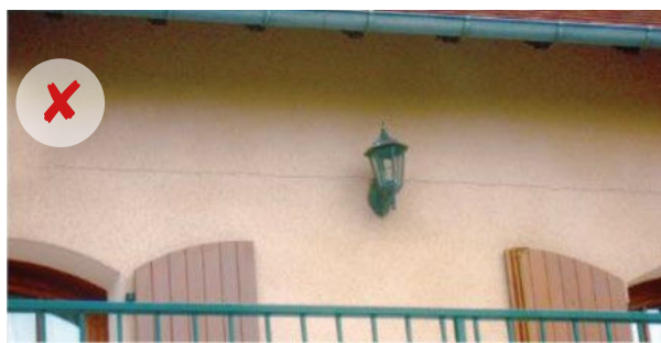
Fissure de plancher caractéristique. Rotation de l'appui du plancher.
