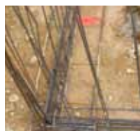
Nœud de chaînage - Continuité mécanique
